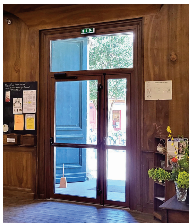
Portes vitrées à l'entrée du temple de Bergerac
